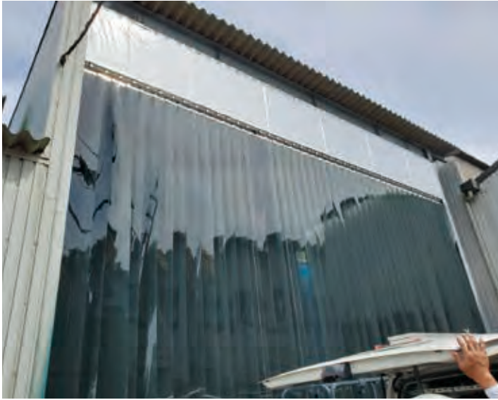
先頭用200Wハンガー(アルミ製、受板SUS製)
