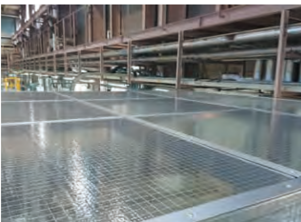
ビニールブース天井部分
